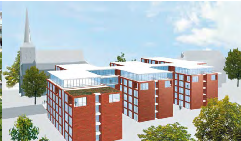
AGAPLESION ELISABETHENSTIFT, Darmstadt, zweiter Bauabschnitt im Bereich Wohnen & Pflegen
